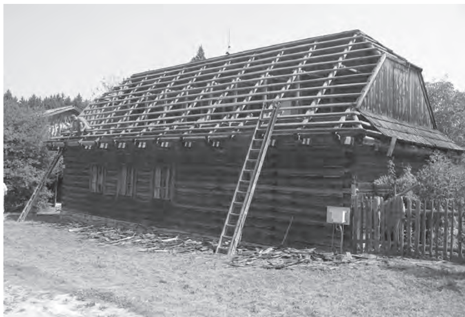
Obr. 6. MSD. Výmena strešnej krytiny na škole z Petrovíc. Foto J. Neplech, 2012
