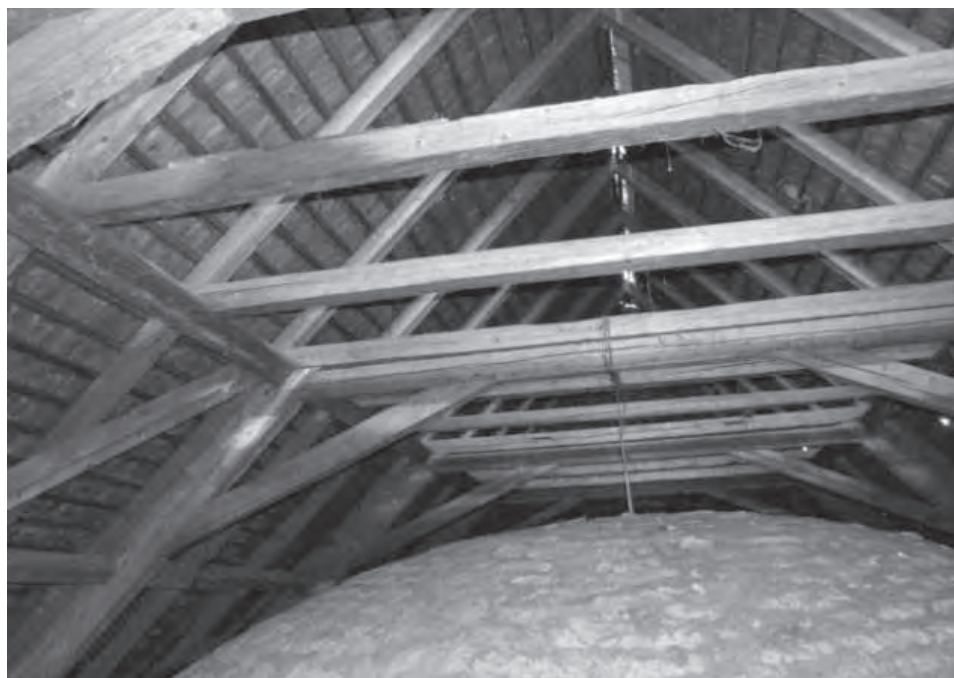
Obr. 8. Martin-Priekopa, r. k. Kostol Povýšenia sv. Kríža. Krov. Foto K. Ďurian, 2008
